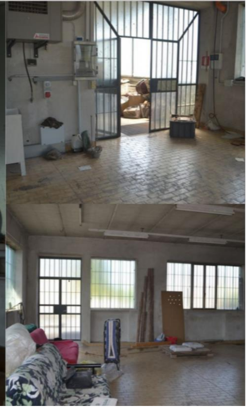
Ingresso 2-Porta pedonale
