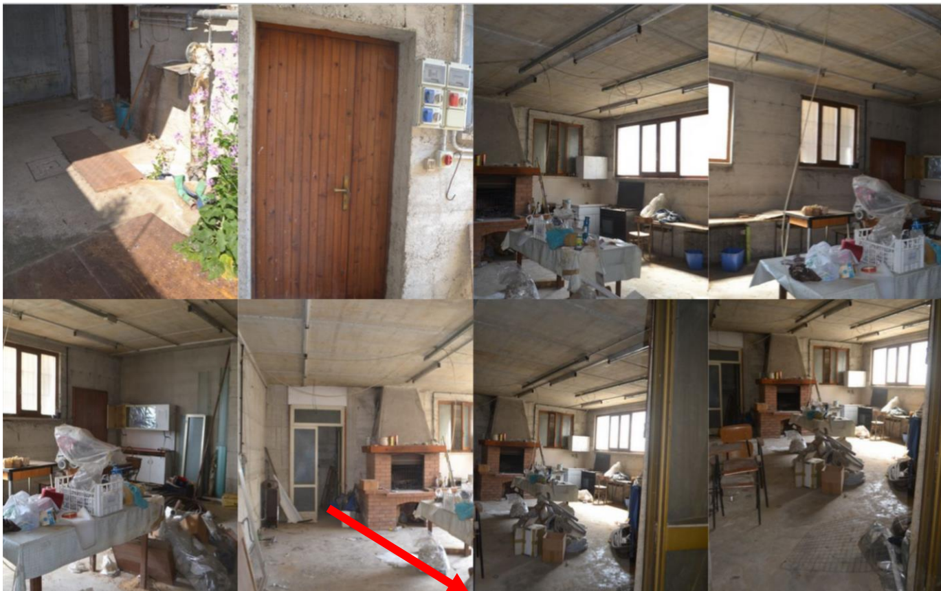
Ingresso pedonale dalla rampa alla Cantina 1 – Ingresso alla Cantina 2
