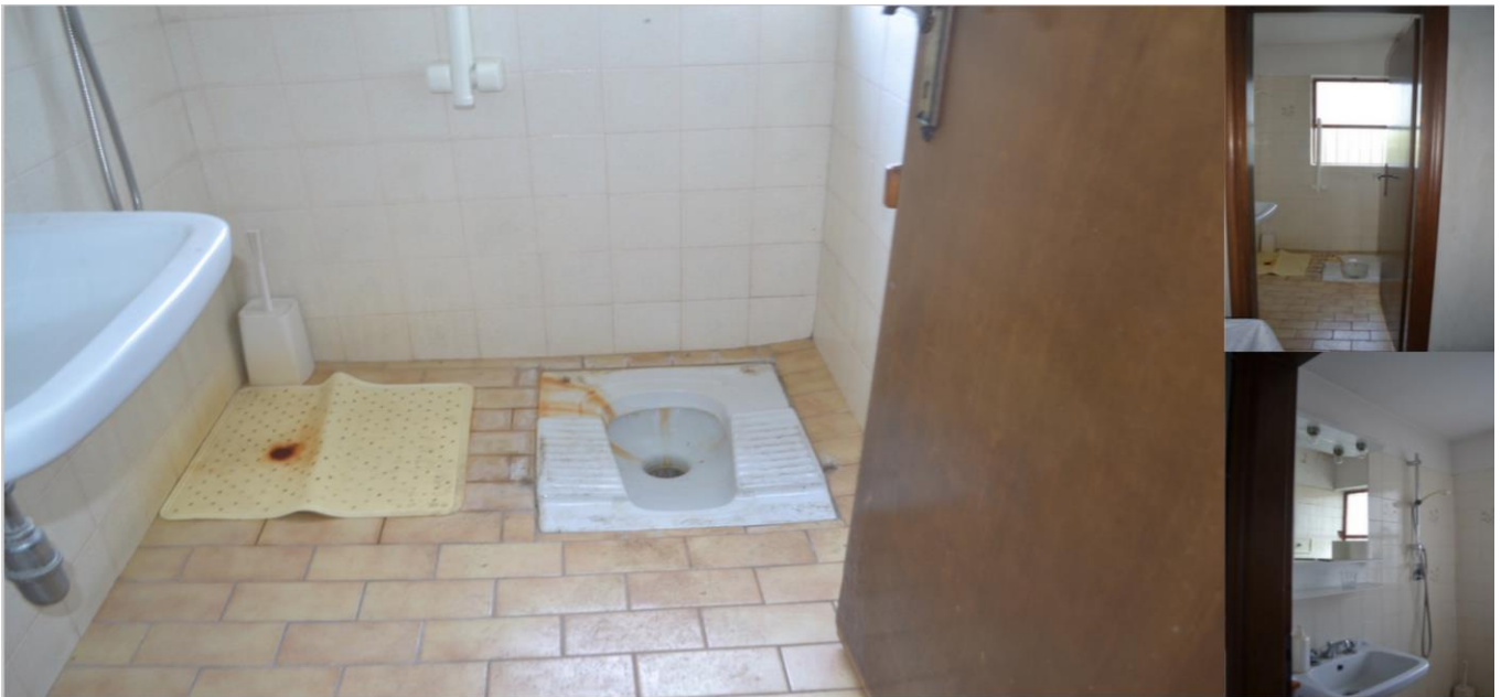
Bagno del laboratorio
