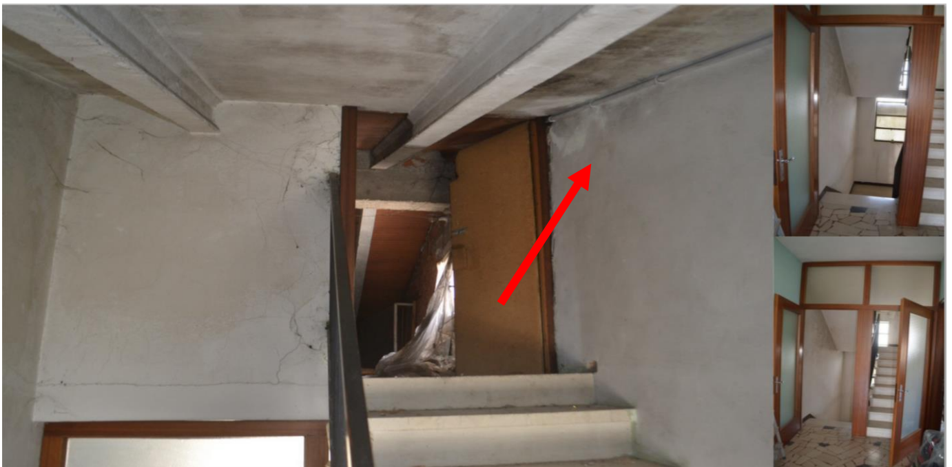
Scala di collegamento interno dal piano primo alla soffitta
