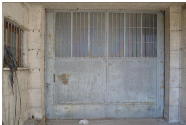
PORTONE SCORREVOLE IN FERRO-VETRO DI ACCESSO AL GARAGE
