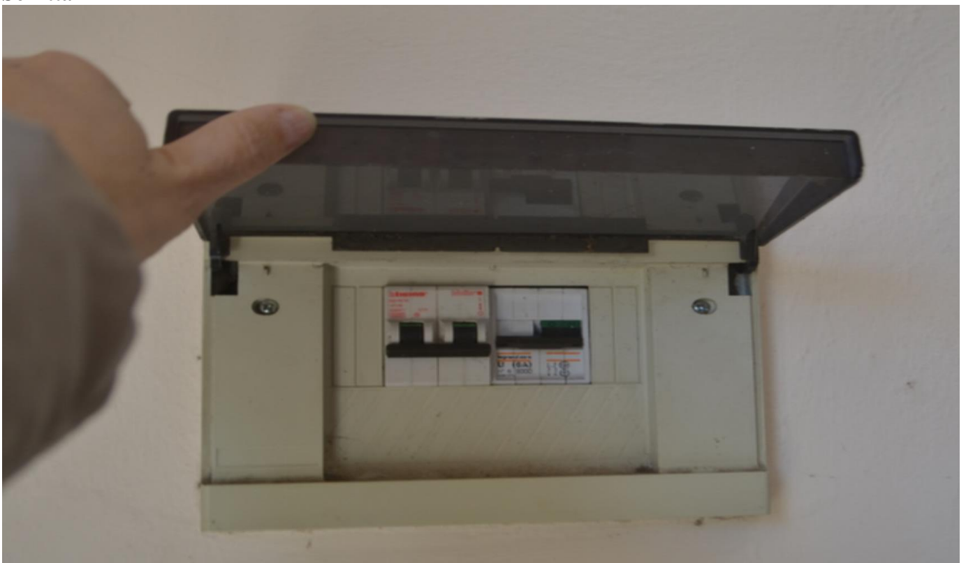
Quadro: Centralino Elettrico
