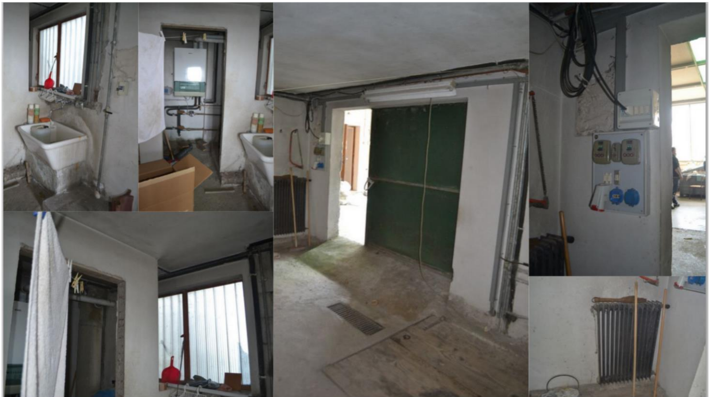
Ingresso 3-Portone in ferro verniciato scorrevole-locale caldaia
