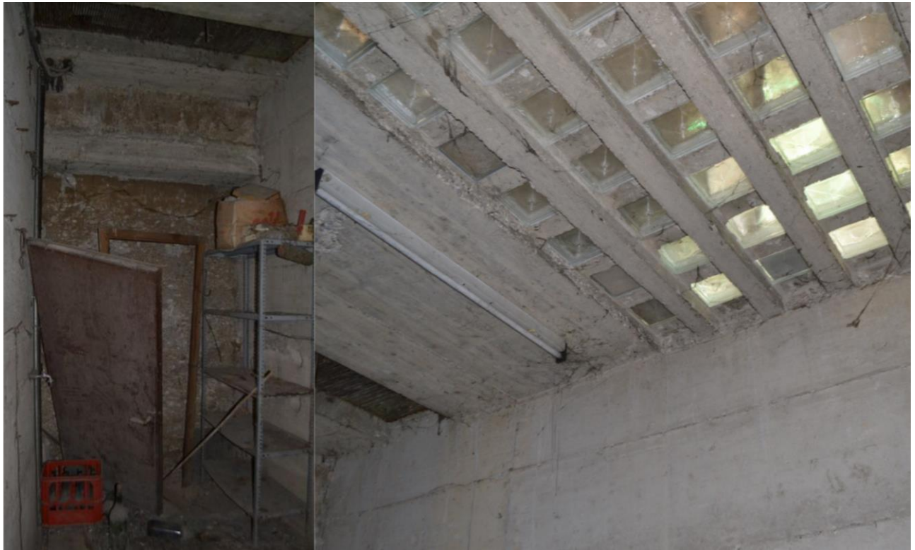
Cantina 2 - ricavata nel sottoscale prende luce dal sovrastante vetrocemento
